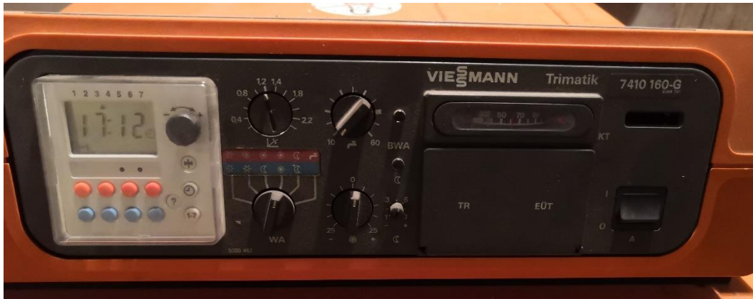
Figure 22 - Panneau de contrôle de la chaudière
