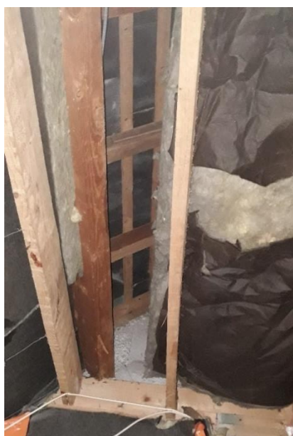
Figure 14 : Défaut dans l'isolation des combles est
