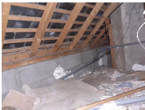
Figure 38 : Absence d'isolation dans les combles
