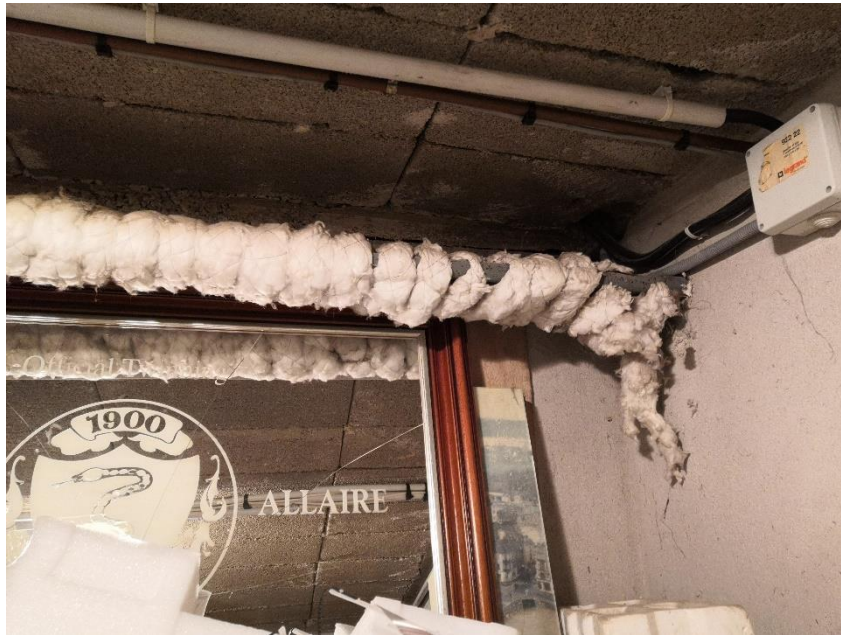
Figure 24 : Isolation dégradée
