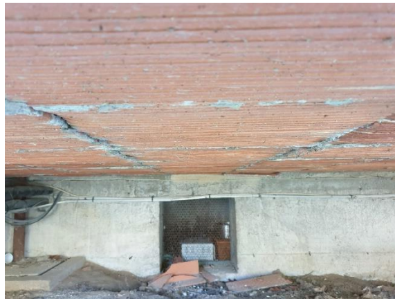
Figure 35 : Absence d'isolation sous le plancher de l'extension de 1980
