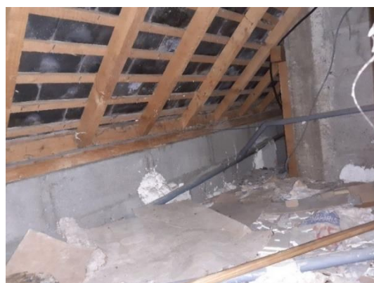
Figure 13 : Combles nord-ouest non isolés
