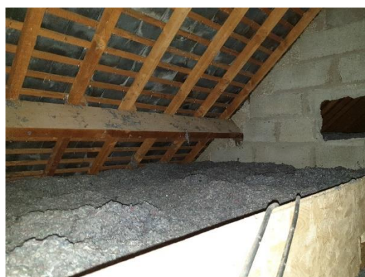
Figure 15 : Toiture isolée par soufflage
